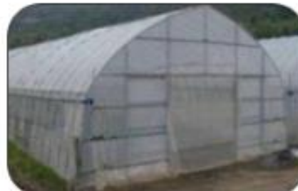
パイプハウス（塩化ビニルフィルム・ポリオレフィン系フィルム）
