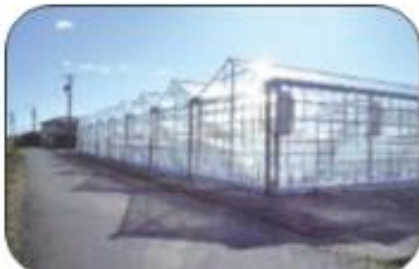
鉄骨ハウス（ポリオレフィン系・その他プラスチックフィルム）
