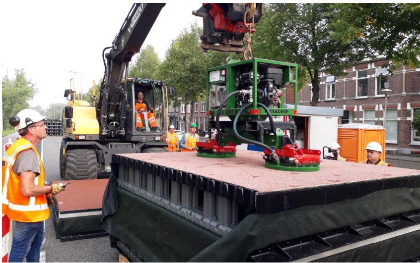
写真：ドイツVolkerWessels社HP 道路舗装：軽量、強度・耐用年数の倍化、管・ケーブル設置、更新容易
